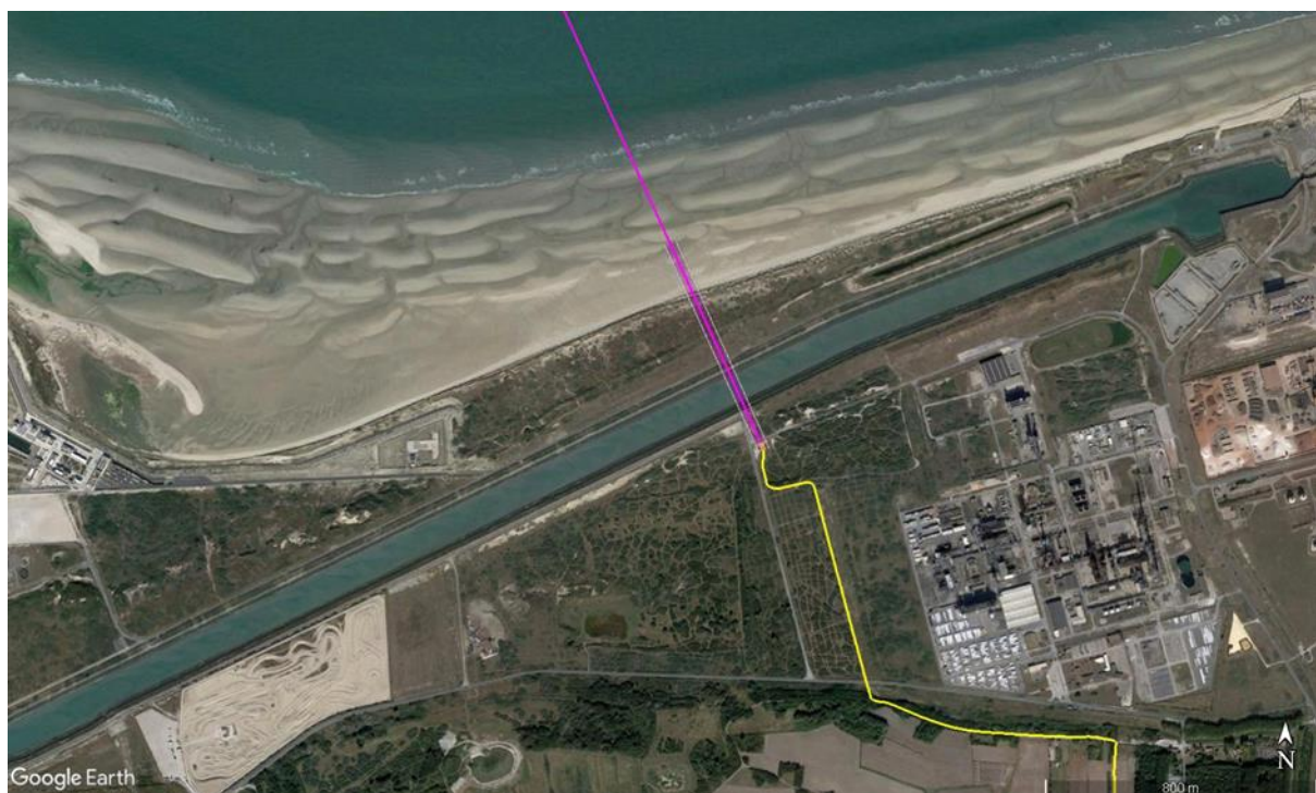
Figure 64 : Forage directionnel horizontal (HDD) à la traversée du rivage de Dunkerque
