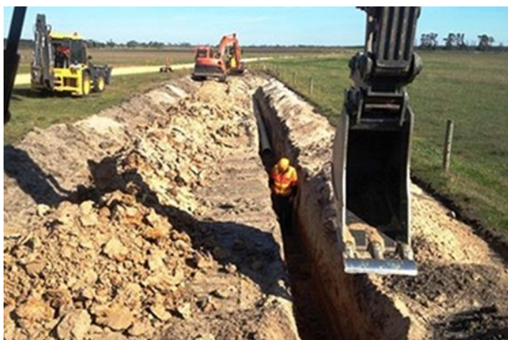
Figure 80 : Creusement de tranchées à ciel ouvert
