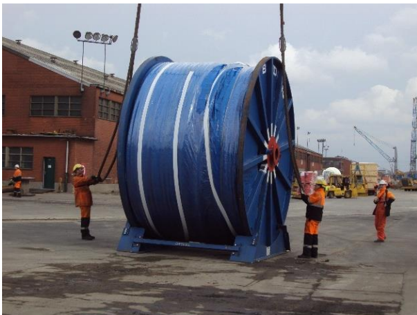
Figure 83 : Transport routier des tourets de câble
