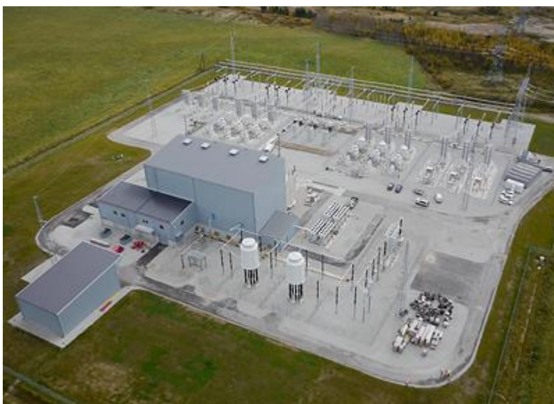
Interconnecteur EstLink 2 de 650 MW (LCC)
