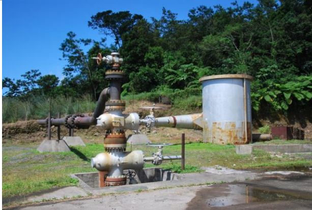
Installation de mesures sur le puits géothermale en Dominique
