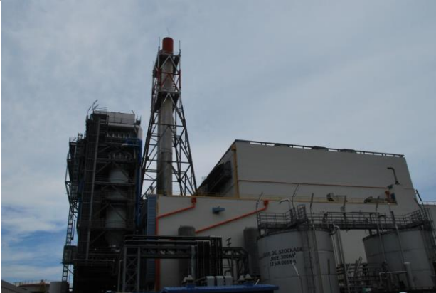
Centrale diesel de Pointe des Carrières
