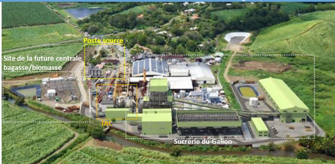
Figure 12 : Site du Galion avant les travaux de la construction de la centrale bagasse/biomasse
