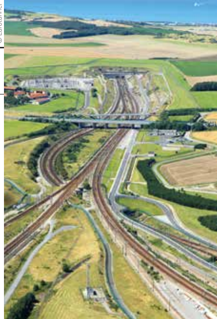
La nouvelle interconnexion ElecLink reliera la France et l'Angleterre en passant par le Tunnel sous la Manche.
