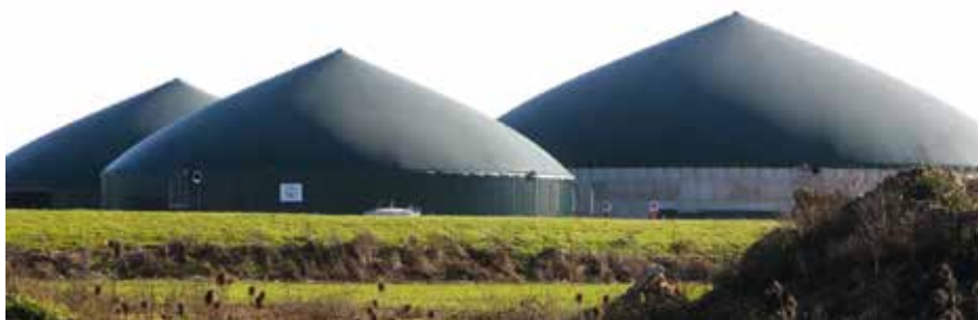
Le site de méthanisation de Bioénergie de la Brie à la ferme de Chaume-en-Brie (77) est la première unité d'injection de biométhane agricole en France. La société Bioénergie de la Brie produit environ 8,5 GWh par an de biométhane qu'elle revend à GrDF, ce qui représente une alimentation en gaz d'environ 680 foyers (usage chauffage).
