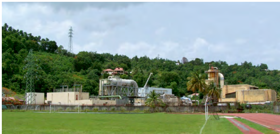
Usine géothermique de Bouillante, en Guadeloupe.
