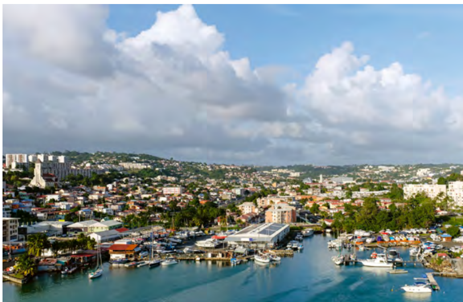
Port de Fort-de-France, en Martinique. Mise en service de la centrale bagasse/biomasse d'Albioma en Martinique (Galion 2) en 2018.
