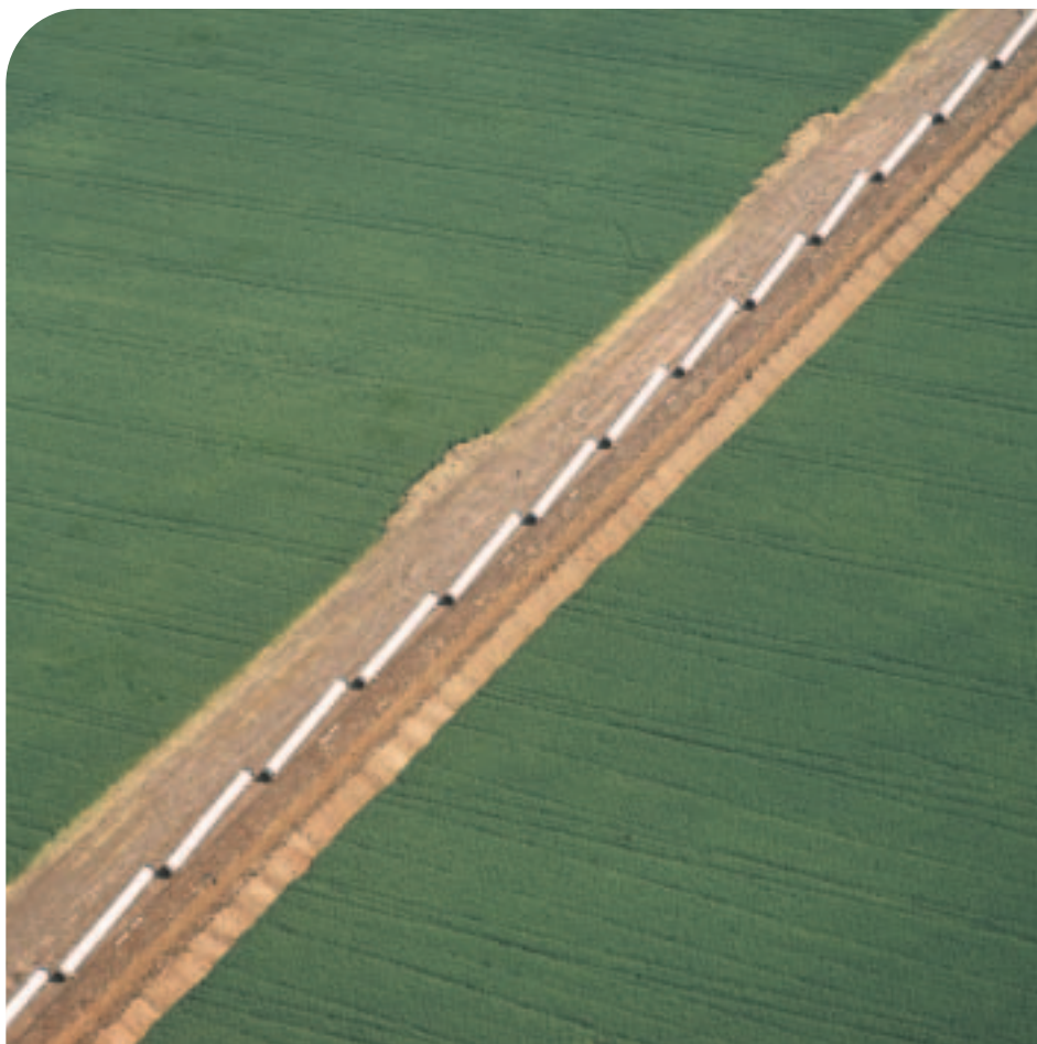
Gazoduc en construction
