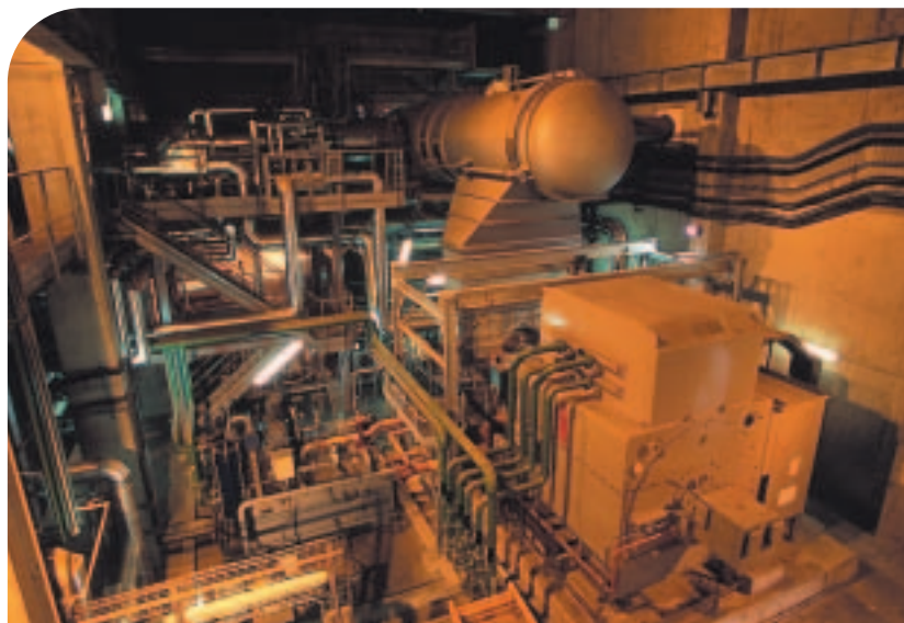
Usine d'incinération d'ordures ménagères de la Communauté Urbaine de Bordeaux
