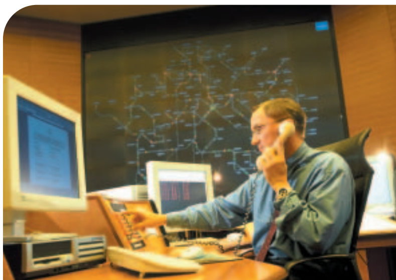
Centre National d'Exploitation du Système (CNES) à Saint-Denis
