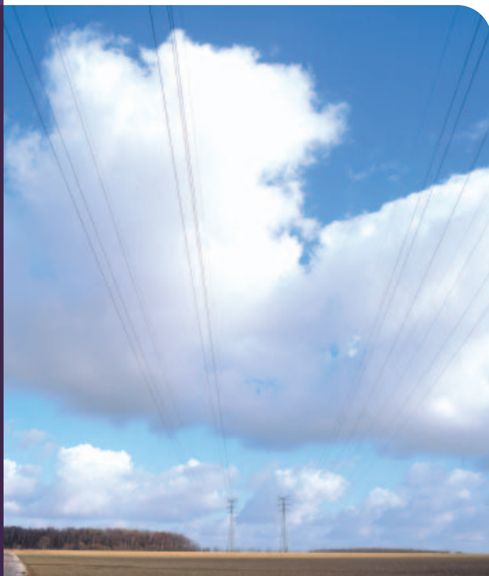
Réseau de transport d'électricité
