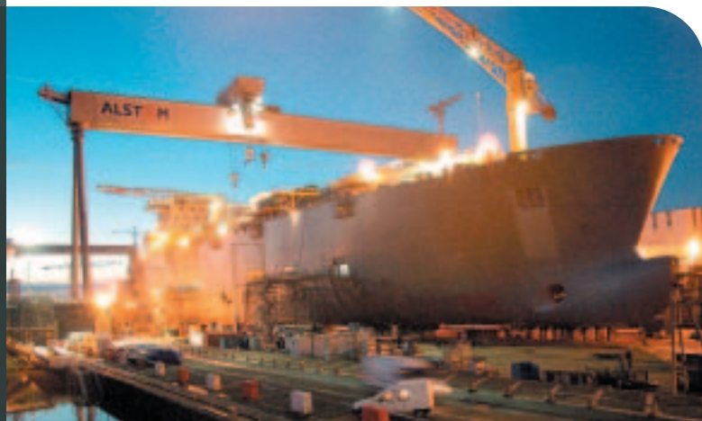
Méthanier en construction aux Chantiers de l'Atlantique à Saint-Nazaire
