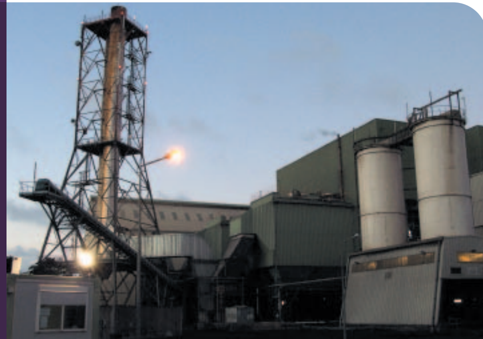
Centrale bagasse-charbon du Moule (Guadeloupe)
